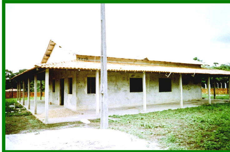
Figura 6- Prédio onde funcionará o Posto de Saúde (Oliveira, 2006)
