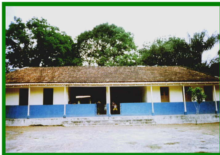
Figura 5- Escola Municipal de Ensino Fundamental José Malcher (Oliveira, 2006)
