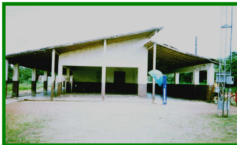
Figura 4- Escola Municipal de Ensino Fundamental Provisória Vila Modelo (Oliveira, 2006)
