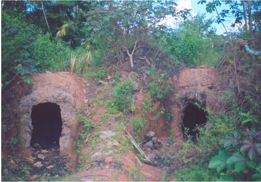
Figura 10: Os fornos de produção de carvão vegetal têm vida útil de até 10 anos de uso intensivo.
